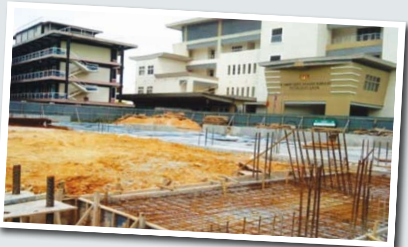
Gambar 9 : Bangunan Tempat Letak Kereta Bertingkat di Kompleks Mahkamah Petaling Jaya
